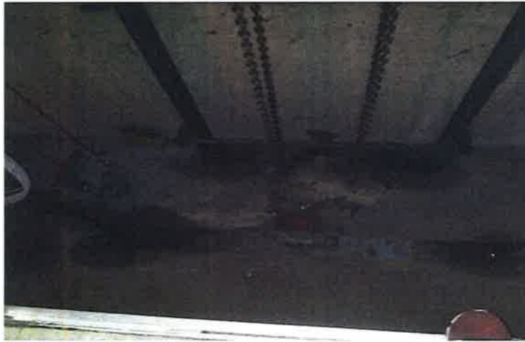
승강로 피트 청소 후
